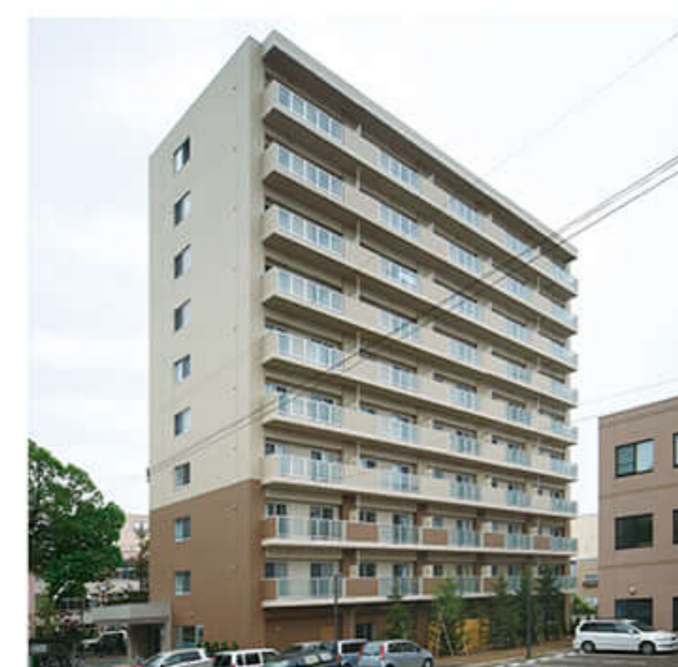
サービス付き高齢者向け住宅アルフレジダンス学園前
