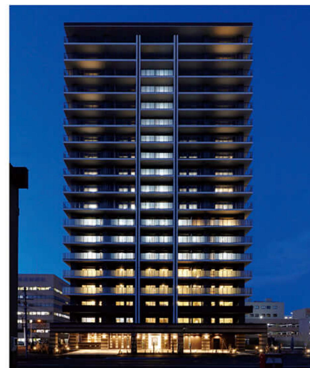
帯広市西3・9周辺地区第一種市街地再開発事業(分譲マンション棟)
